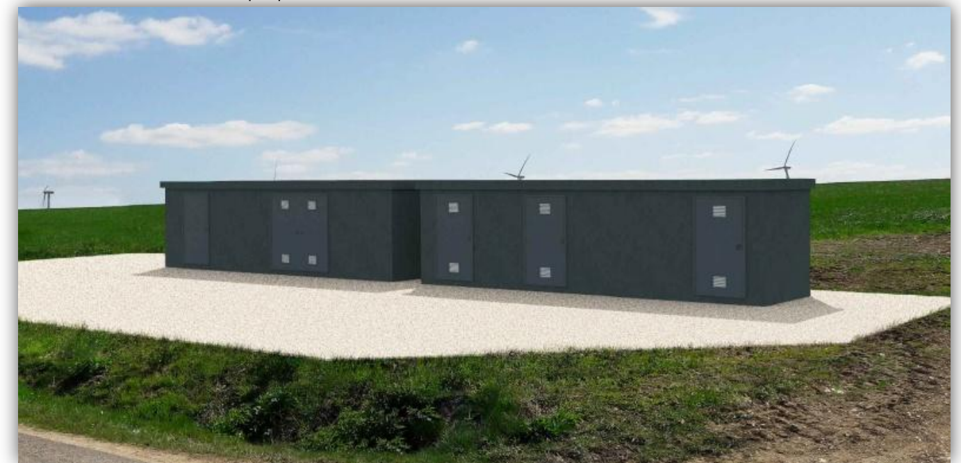
Figure 68 : Habillage du poste de livraison du parc
